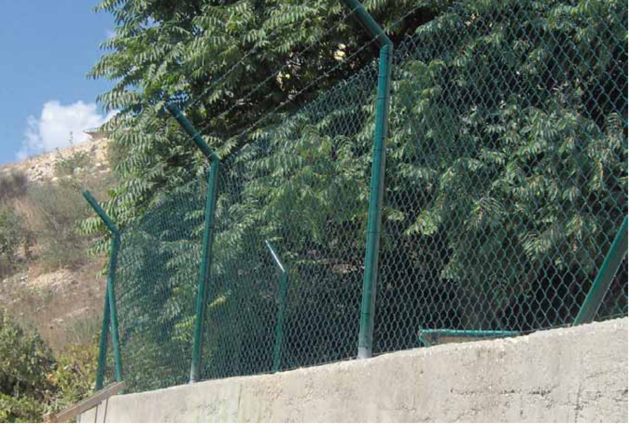
Galvaniz üzeri PVC kaplı örgü tel uygulaması ve dikenli tel uygulaması, polyester kaplı direk ve payandalar. Galvanized & PVC coated chainlink fence & barbed wire application - polyester coated post & braces.
