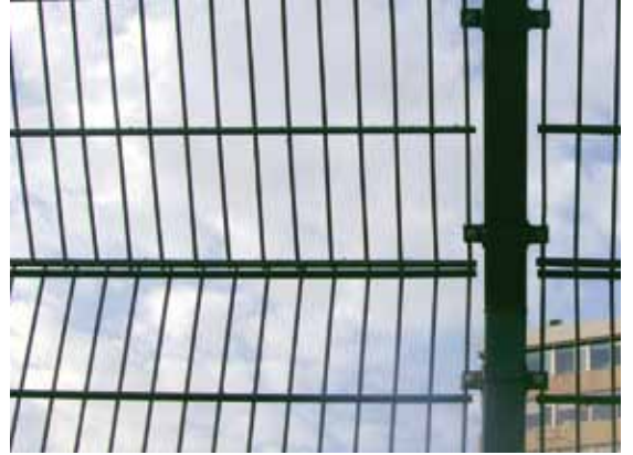
Asdouble panel uygulaması. Direk tipi 60x60 mm. Kelepçe tipi: Metal Asdouble panel fence installation with 60x60 mm post & metal bracelet.
