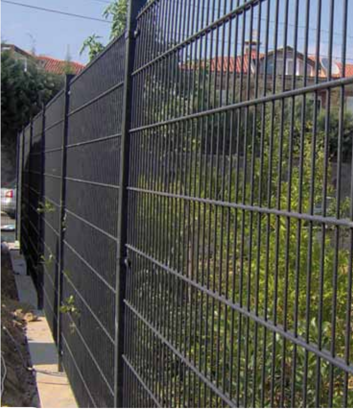
Asdouble panel uygulaması. Direk tipi 60x60 mm. Kelepçe tipi: Metal Asdouble panel fence installation with 60x60 mm post & metal bracelet.
