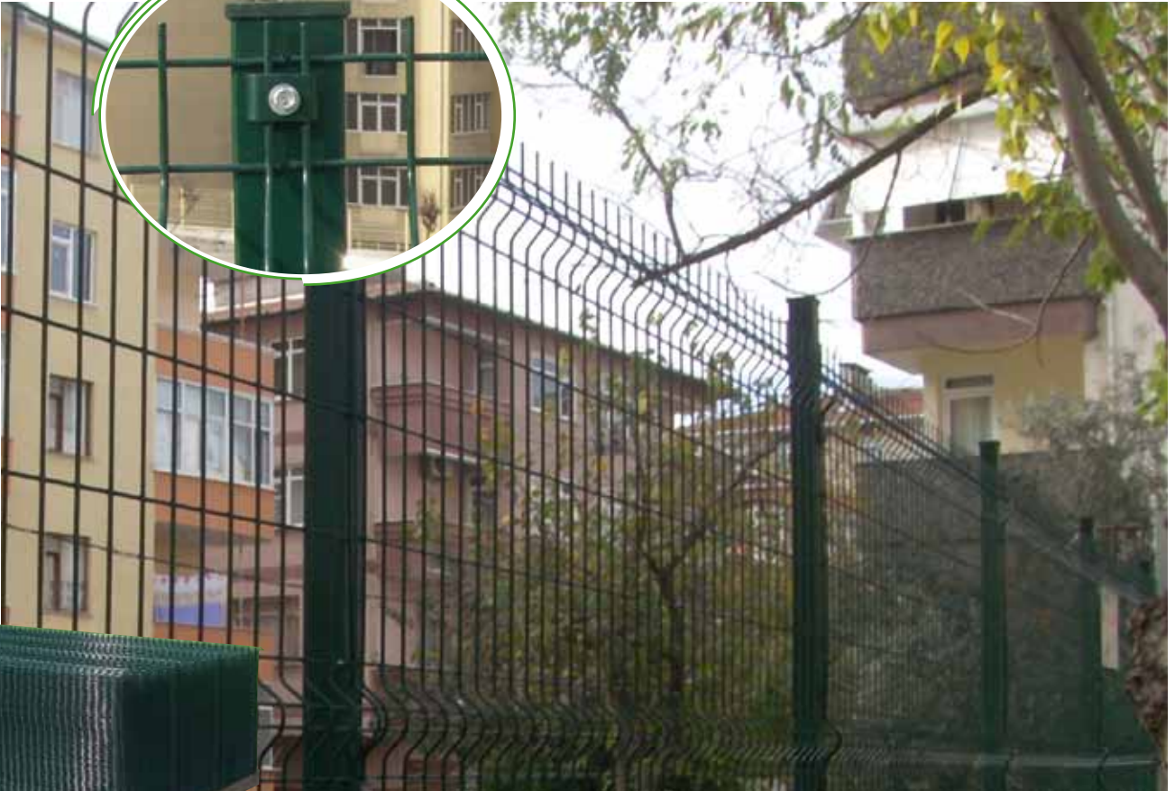
Metal klips ile panel çit uygulaması. Panelfence installation is made by metal clips.
