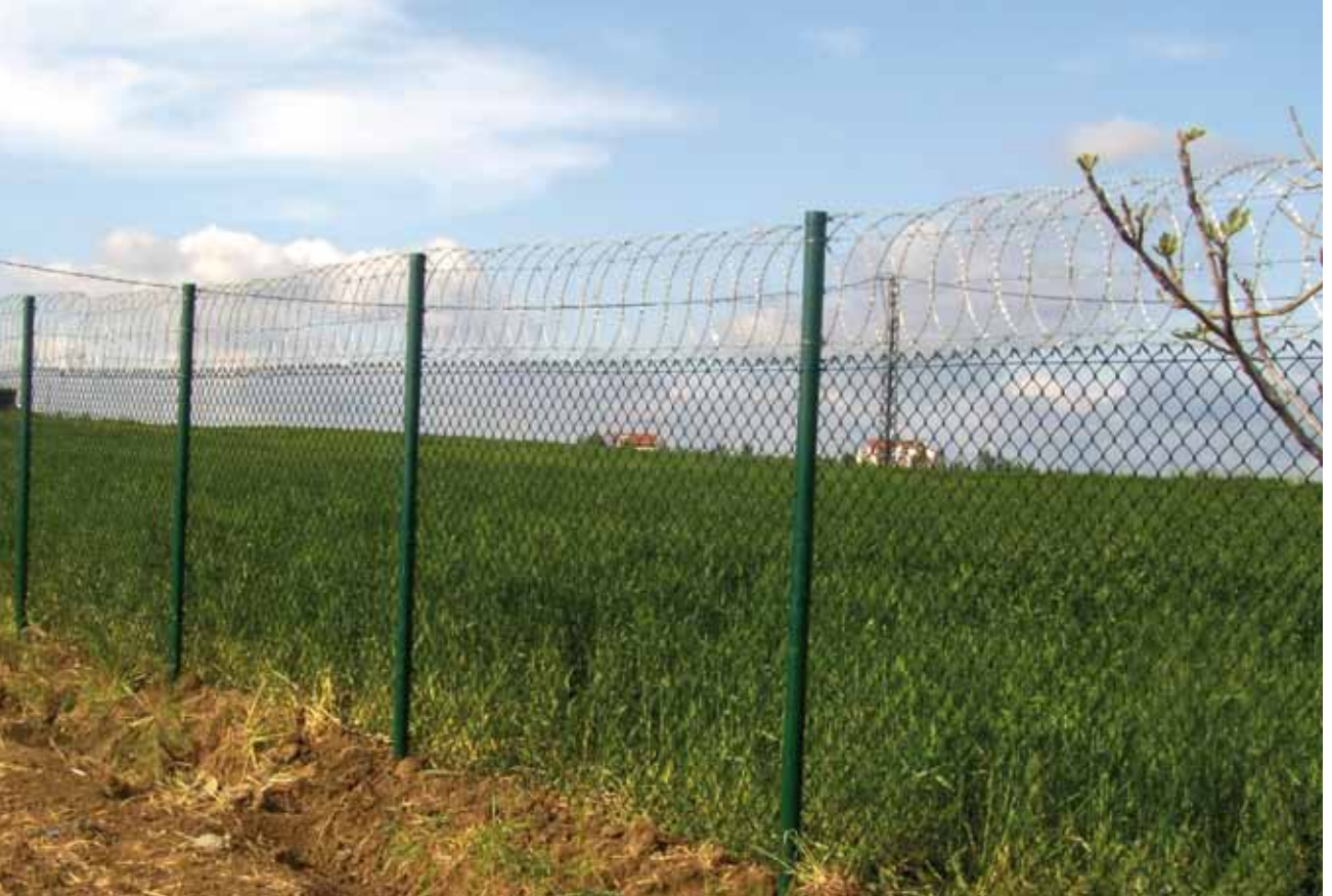
Galvaniz üzeri PVC kaplı örgü tel uygulaması ve düzlemsel jiletli tel uygulaması, polyester kaplı direk ve payandalar. Galvanized & PVC coated chainlink fence & flat wrapped razor wire application - polyester coated post & braces.
