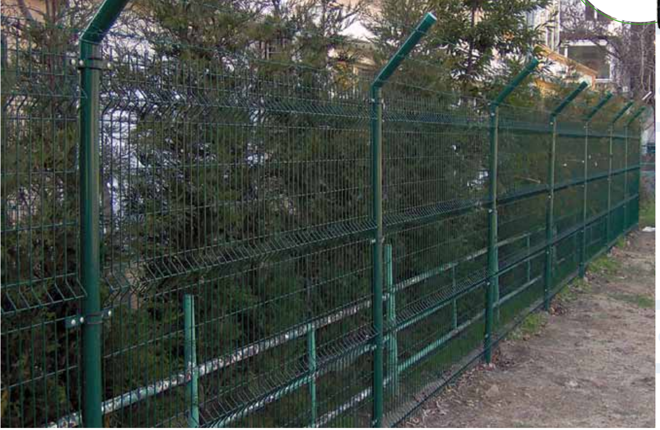
Panelçit uygulaması ve üç sıra Galvaniz & PVC kaplı dikenli tel uygulaması. Panelfence and three rows of galvanized & PVC coated barbed wire application.
